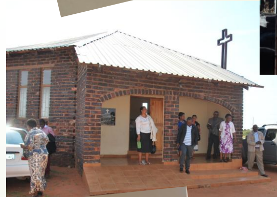
Das frühere Kirchengebäude
